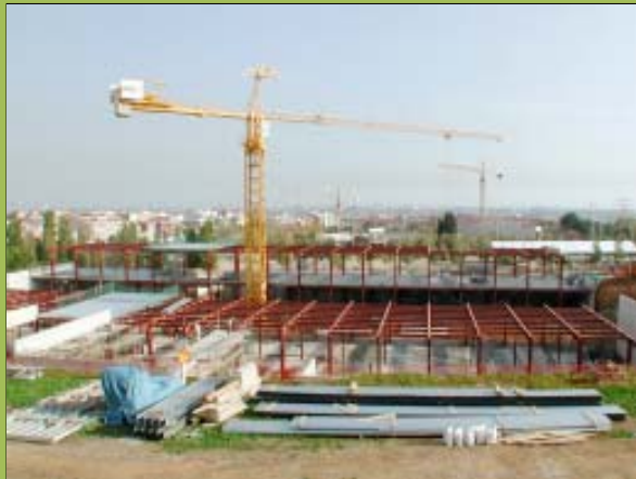
Las fichas 'sostenibles' ya se están utilizando durante las obras de construcción de la Biblioteca Central de Sant Boi
