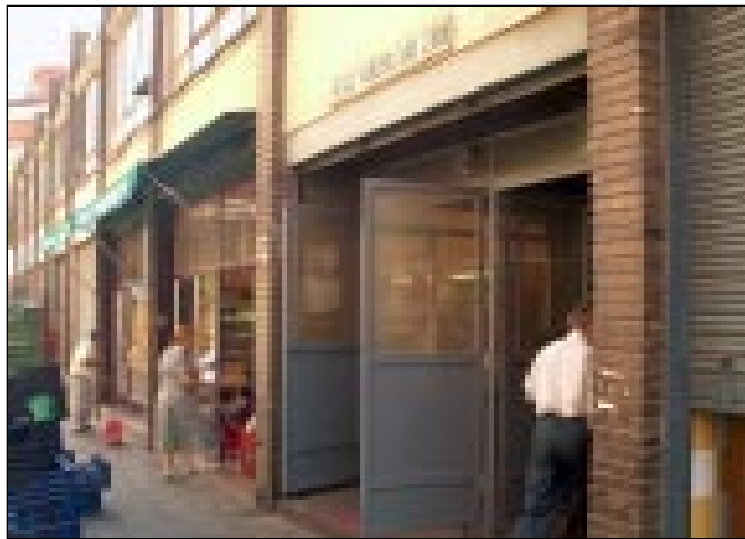
El Mercat de Sant Jordi se derribará para construirlo de nuevo sobre el mismo emplazamiento
