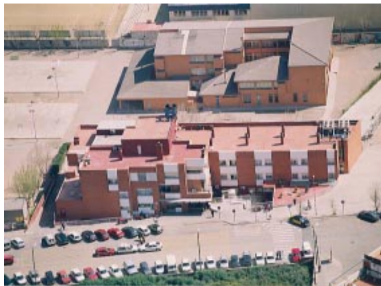
Les obres que es faran a l'hospital són una peça clau per completar la reforma sanitària al municipi
